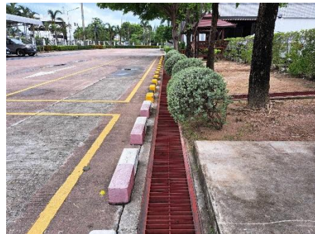
ภาพที่ 2.1-21 รางระบายน้ำเดิมของโครงการ บริเวณ พื้นที่ก่อสร้าง
