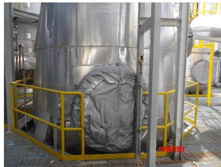
ภาพที่ 2.1-2 Catalytic Emission Control System
