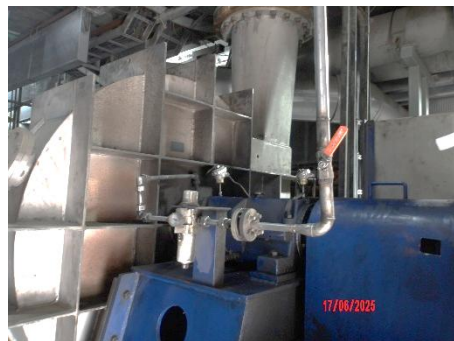
ภาพที่ 2.1-29 การติดตั้งกล่องวงจรปิดและอุปกรณ์วัดความดัน ภายในห้องเครื่องเป่าอากาศ (Blower Room)
