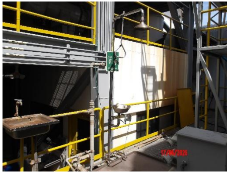
ภาพที่ 2.1-27 ที่ล้างตาและฝักบัวฉุกเฉิน
