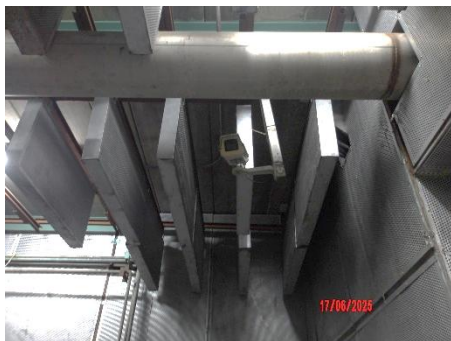
ภาพที่ 2.1-29 การติดตั้งกล่องวงจรปิดและอุปกรณ์วัดความดัน ภายในห้องเครื่องเป่าอากาศ (Blower Room)
