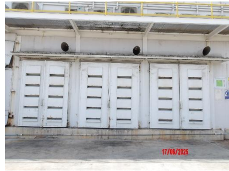
ภาพที่ 2.1-16 วัสดุปุ๋ยรองและห้องครอบ/ฝาครอบ เครื่องจักรที่มีเสียง
