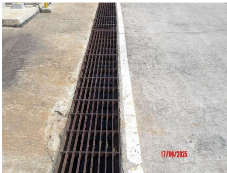
ภาพที่ 2.1-11 ระบบระบายน้ำฝนทั่วไป และน้ำฝนปนเปื้อน
