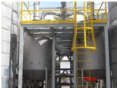
ภาพที่ 2.1-34 หอดูดซับด้วยถ่านกัมมันต์ (Adsorber)
