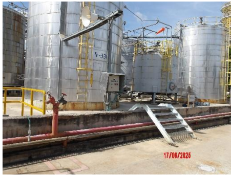
ภาพที่ 2.1-32 คั่นคอนกรีตล้อมรอบถังเก็บฟอร์มัลดีไฮด์
