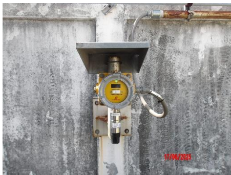
ระบบตรวจจับก๊าซฟอสฟอรัส
