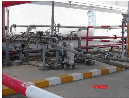
ภาพที่ 2.1-33 ระบบ Vapor Return Line บนถังกักเก็บ ฟอร์มัลดีไฮด์ และเมทานอล
