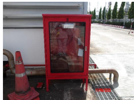
เก็บสายฉีดน้ำดับเพลิงตู้เก็บสายฉีดน้ำดับเพลิง
