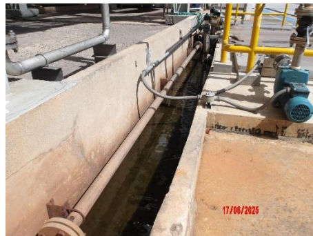
ภาพที่ 2.1-11 ระบบระบายน้ำฝนทั่วไป และน้ำฝนปนเปื้อน
